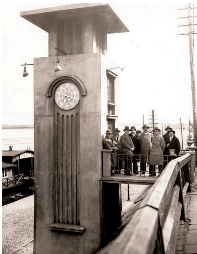
□ Laminigraf, projektu Kazimierza Rodowicza (ojca słynnego „Anody”). W latach 30. stał obok mostu Kierbedzia, wskazując poziom wody na tarczy zegarowej. Przetrwał 40 lat. Rozebrano go w latach 1972-74 w trakcie budowy Wislostrady.
