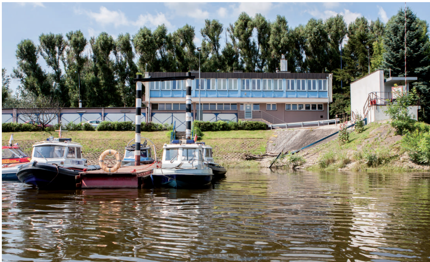
□ Współczesne zdjęcie budynku przy ulicy Ratuszowej. Port Praski - nowa siedziba Komisariatu Rzecznego Policji
