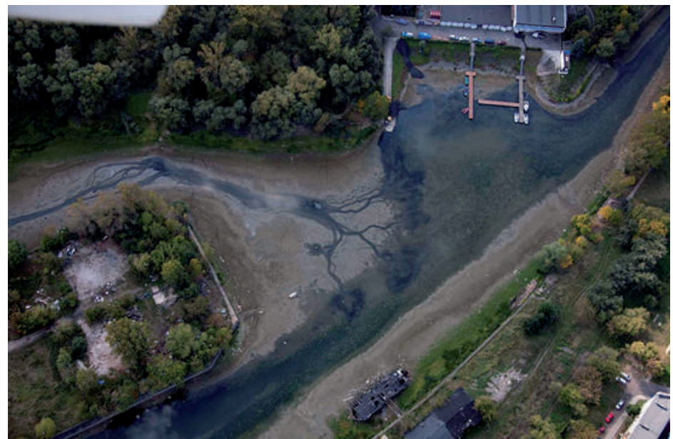
Zdjęcie lotnicze Portu Praskiego w czasie niżówki we wrześniu 2012 r. osuszoną przystanią Policji Rzecznego i nieprzejezdnym kanałem portowym
