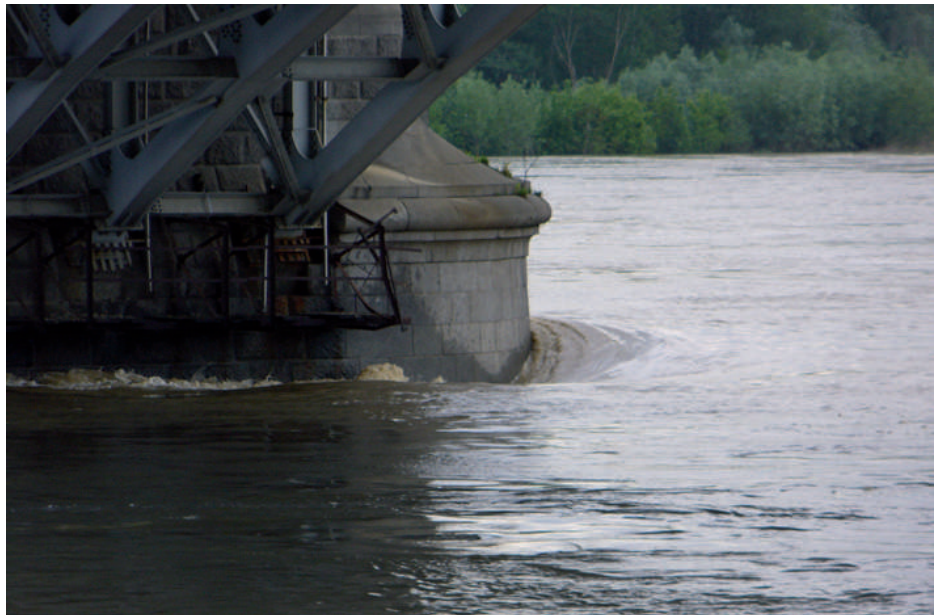
□ Odskok hydrauliczny przy podporze Mostu Poniatońskiego w Warszawie w czasie powodzi na Wiśle 21 maja 2010 r.
